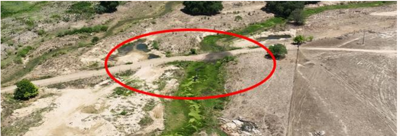
Figura 3.6 - Imagem de drone destacando possível construção irregular de passagem molhada.
