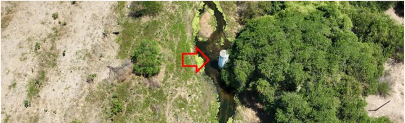
Figura 3.5 - Imagem de drone destacando estrutura construída dentro da calha do rio.
