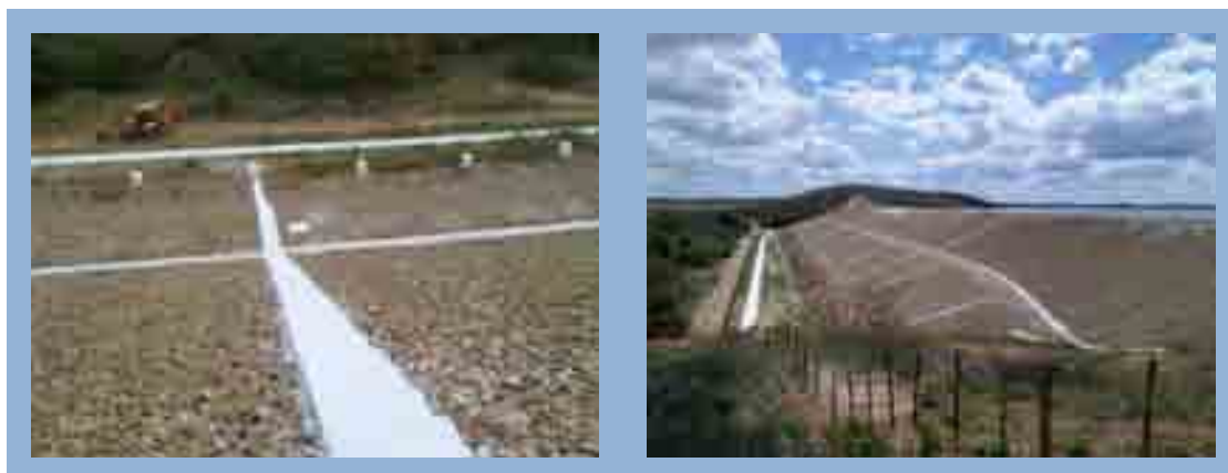
Figura 05 – Escada no talude de jusante.
