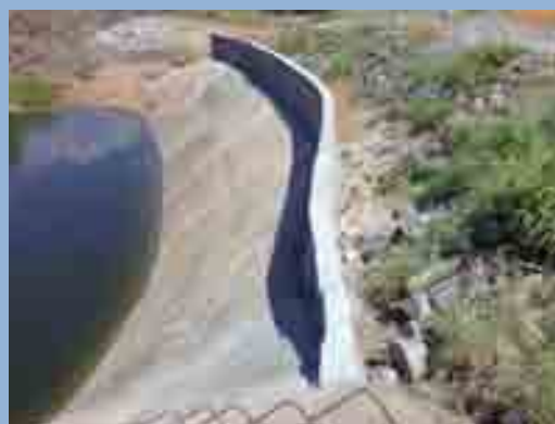
Figura 10 – Muro da bacia alteado.
