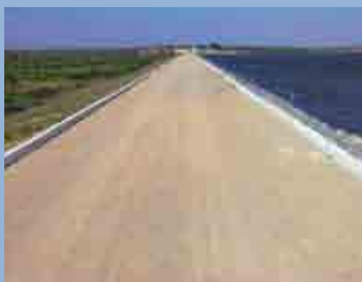
Figura 16 – Coroamento após a intervenção.
