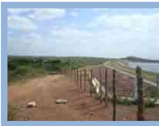
Figura 53 – Barragem Flor do Campo
