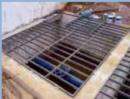
Figura 32 – Caixa de válvulas após a recuperação.
