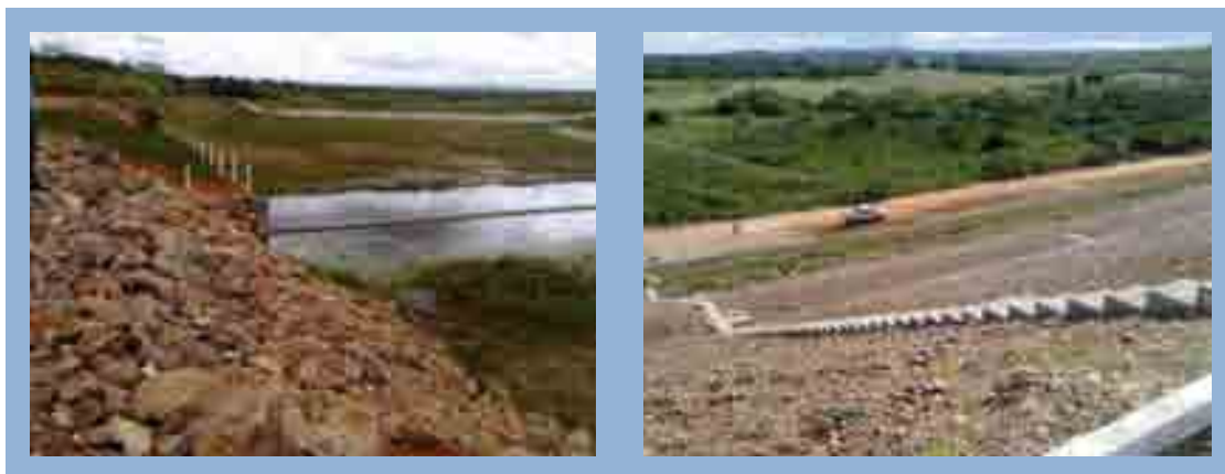
Figura 13 – Estabilização do canal de restituição.
