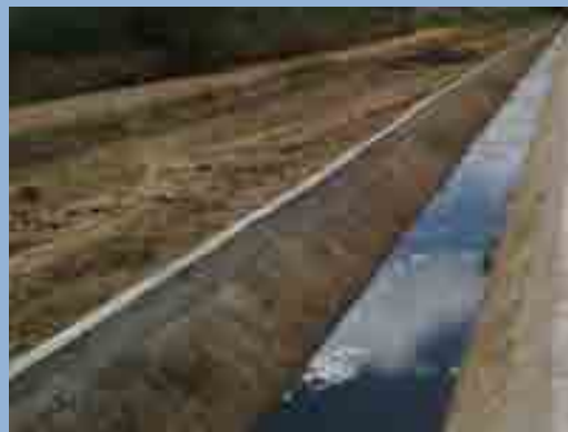
Figura 12 – Alteamento do canal dos poços de alívio.
