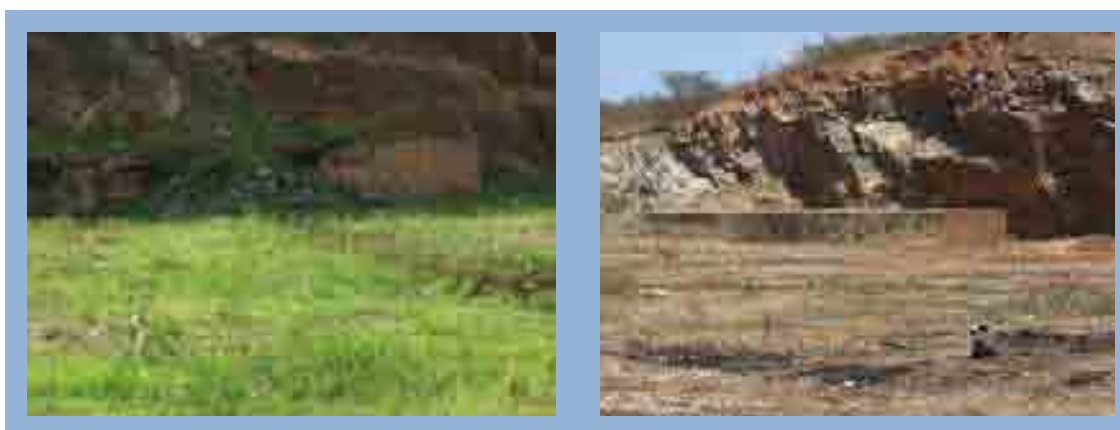
Figura 43 – Canal do vertedouro com vegetação.
