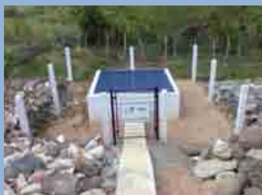
Figura 24 – Caixa de válvulas após a recuperação.
