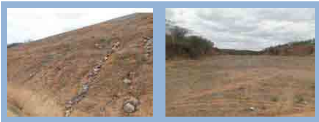
Figura 47 – Enrocamento nas erosões do talude.
