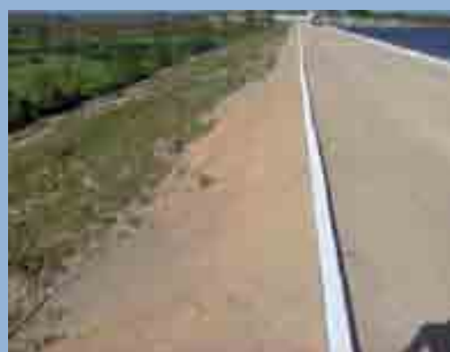
Figura 20 – Talude após a recuperação.
