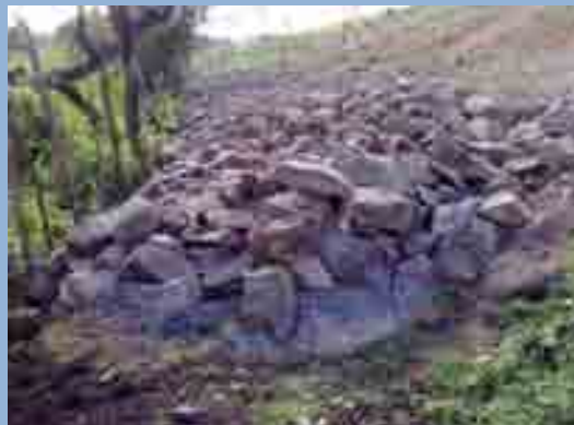
Figura 22 – Dreno invertido executado no pé do talude.
