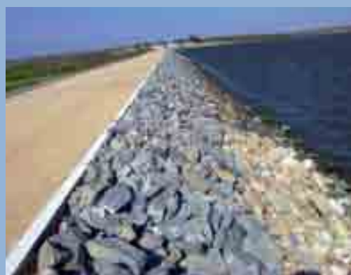
Figura 18 – Talude após a recuperação.
