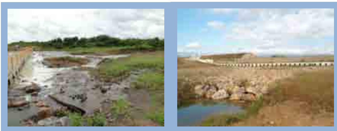
Figura 49 – Erosões regressivas no vertedouro.
