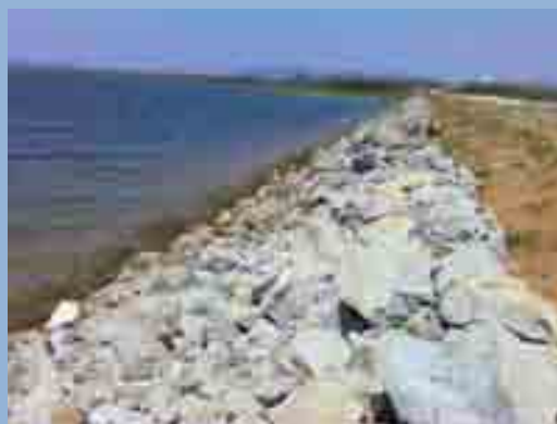
Figura 26 – Rip-rap no talude após intervenção.
