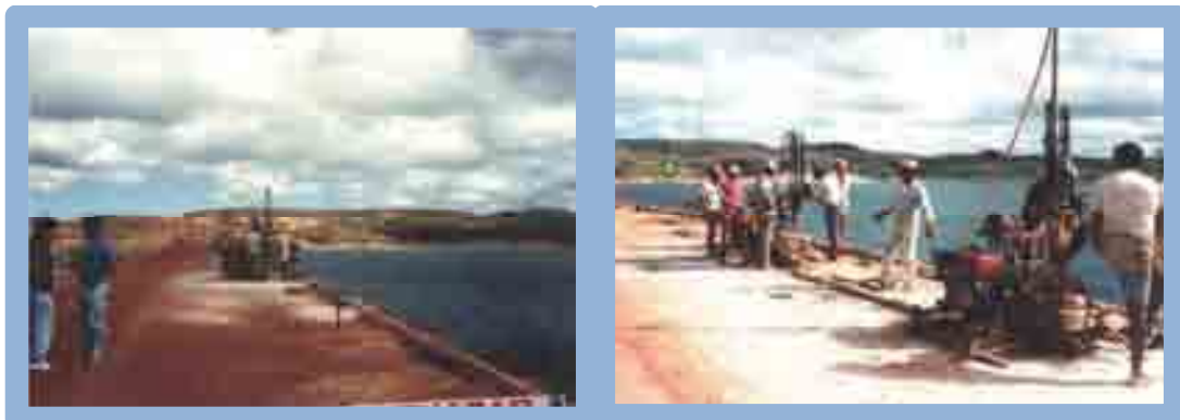
Figura 02 – Impermeabilização por injeção de cimento na fundação (1993).
