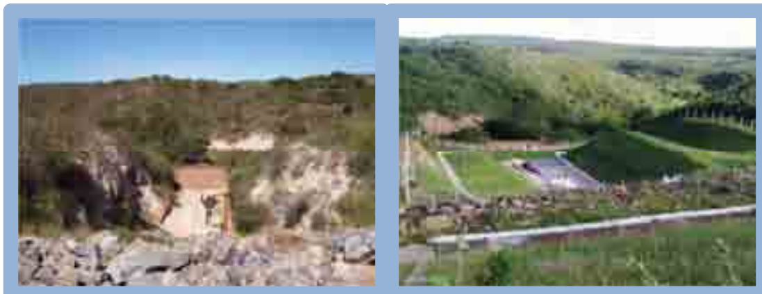
Figura 06 – (Esquerda) Região da tomada d'água antes da intervenção; (Direita) Região da tomada d'água após a intervenção.
