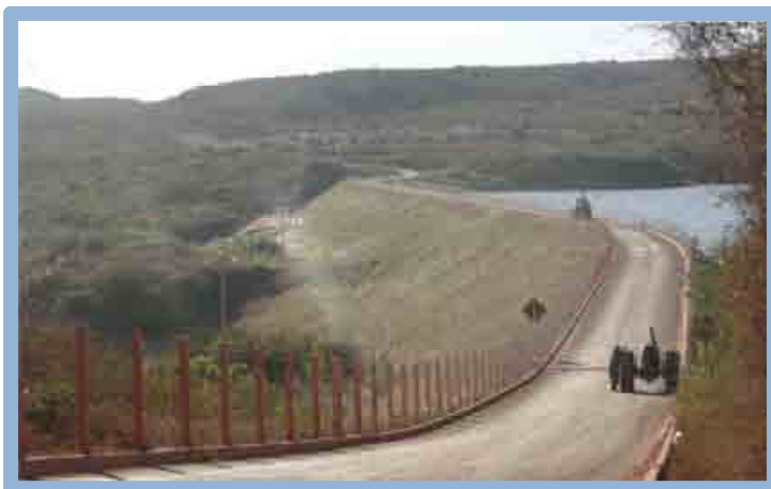
Figura 08 – Visão Geral da Barragem Jaburu I (2011).
