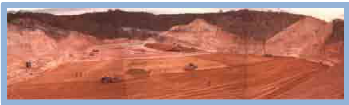
Figura 01 – Construção do Maciço (1983).
