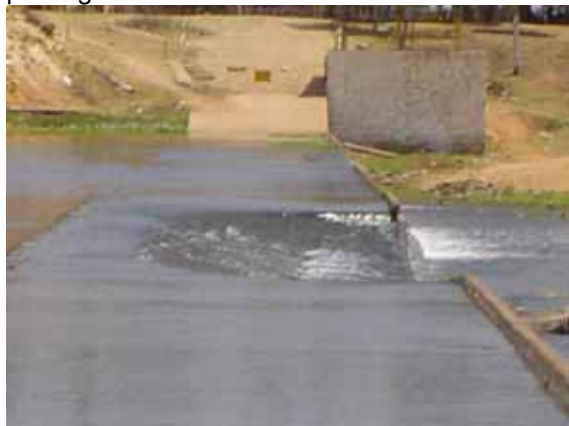
Desvio de vazões no trecho danificado
