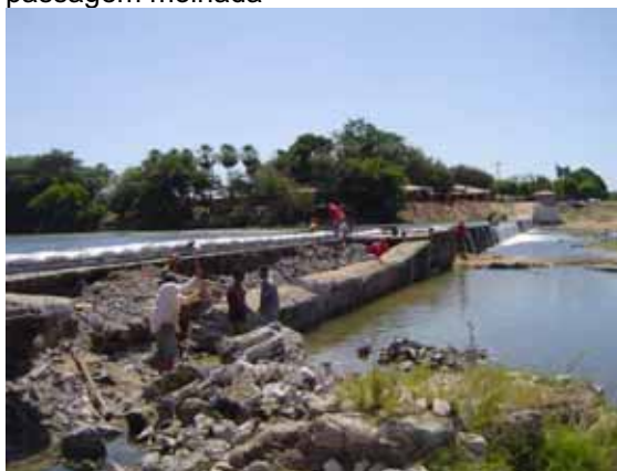
Reconstrução do muro no trecho rompido (a)
