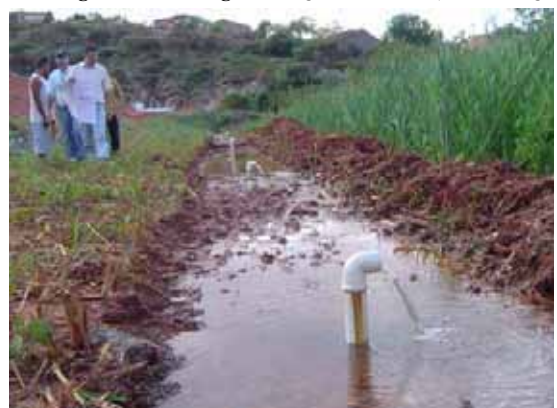
Barragem Olho D'Água - Poços de Alívio (em execução)
