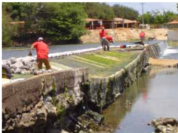
Reconstrução do muro no trecho rompido (a)
