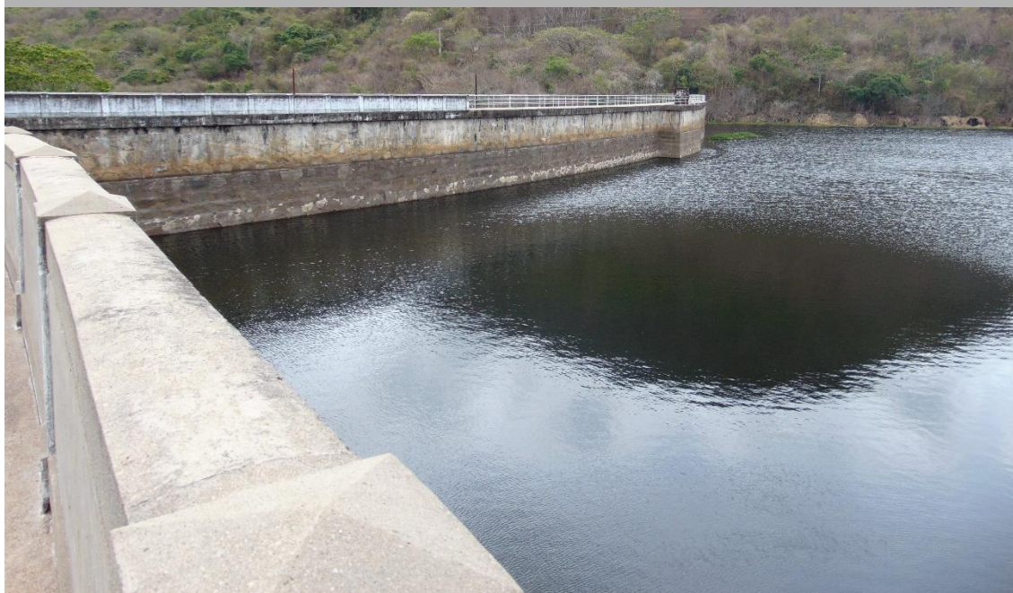
Açude Acarape do Meio – Foto: Cogeh
