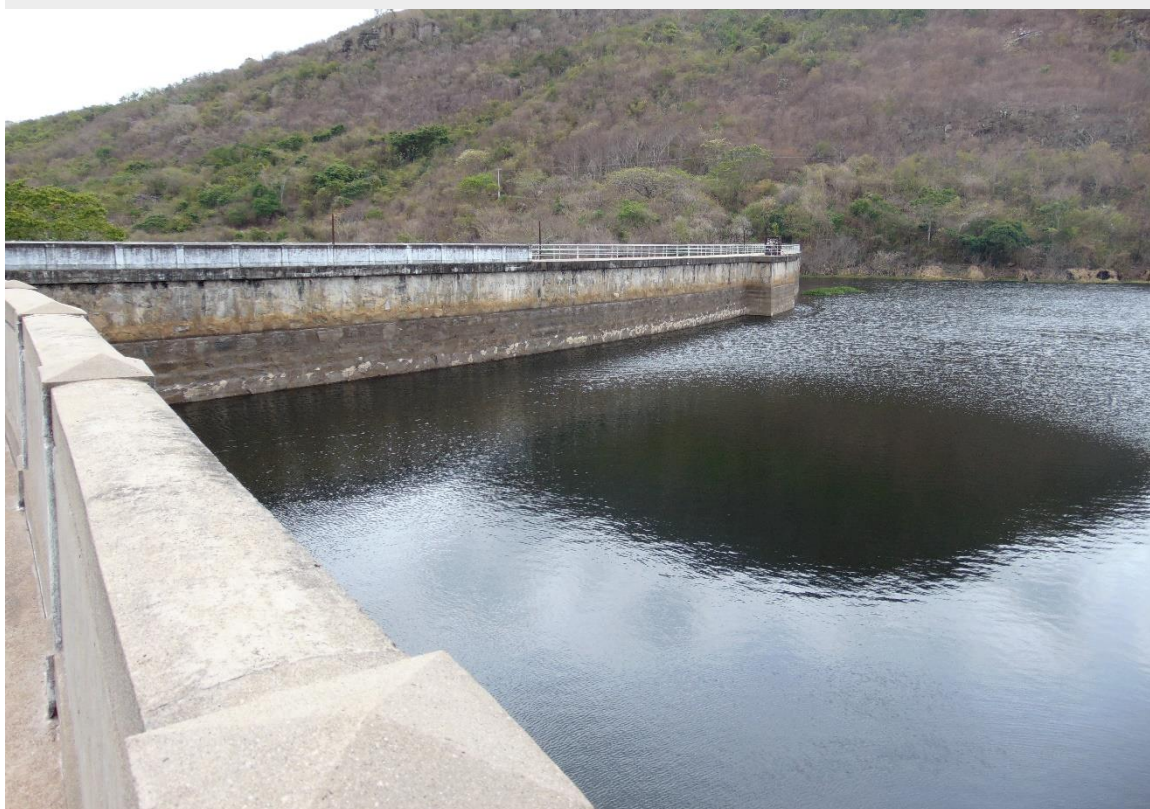
Açude Acarape do Meio – Foto: Cogeh
