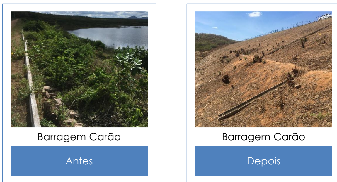
FIGURA 20 - OBRA DE RECUPERAÇÃO NA BARRAGEM CARÃO.
