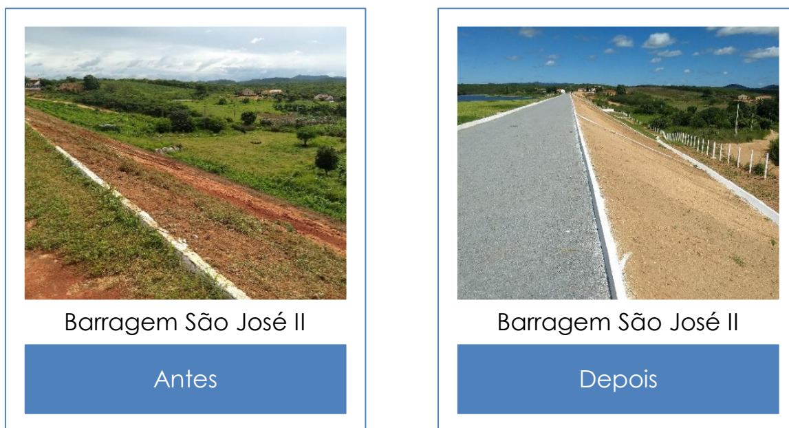
FIGURA 19 - OBRA DE RECUPERAÇÃO NA SÃO JOSÉ II
