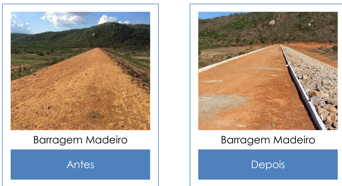
FIGURA 21 - OBRA DE RECUPERAÇÃO NA BARRAGEM MADEIRO.
