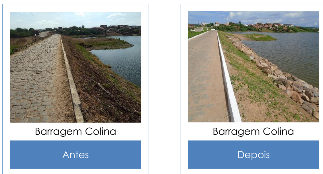
FIGURA 18 - FOTOS ANTES E APÓS A OBRA DE RECUPERAÇÃO NA BARRAGEM COLINA
