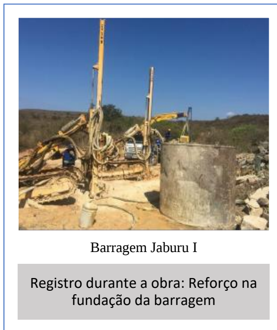
Figura 18 – Conjunto Rotopercussivo e Sistema de Injeção Pressurizada na Barragem Jaburu I
