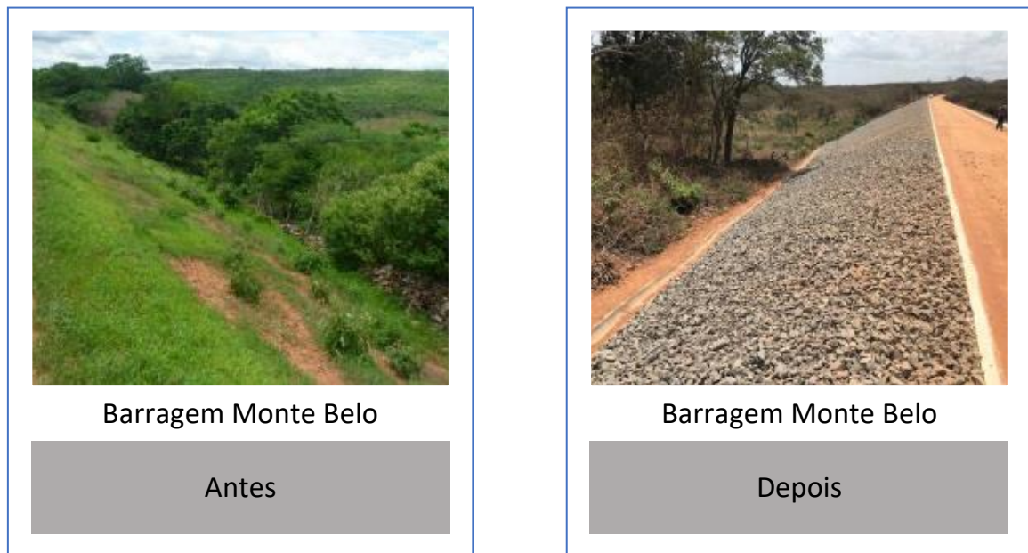
Figura 15 - Obra de Recuperação na Barragem Monte Belo
