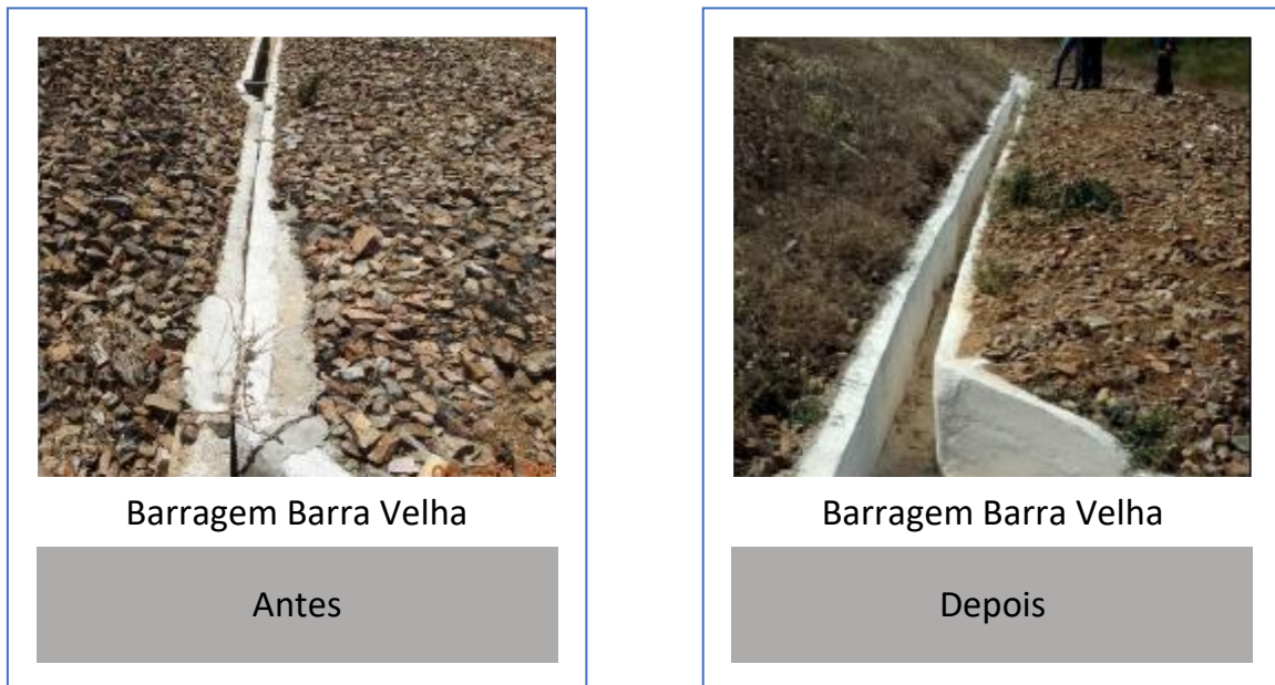
Figura 13 - Fotos Antes e Após a Obra de Recuperação na Barragem Barra Velha
