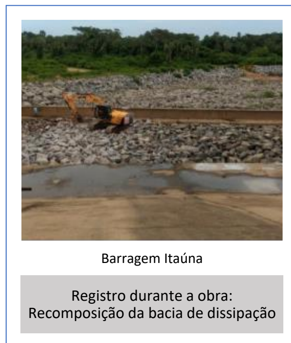
Figura 17 – Foto durante a Obra de Recuperação na Barragem Itaúna
