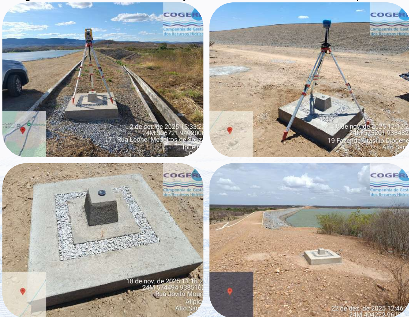
Figura 4 - Monitoramento e Execução de Marcos de Deslocamento Superficial
