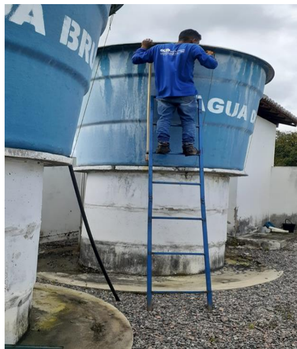
Comunidade Riacho da Pedras – Santa Quitéria. Troca do reservatório de água doce (Maio 2022)
