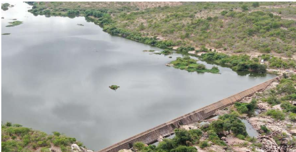
Barragem Caldeirões, Saboeiro – Fonte: Gerência Regional da Cogerh
