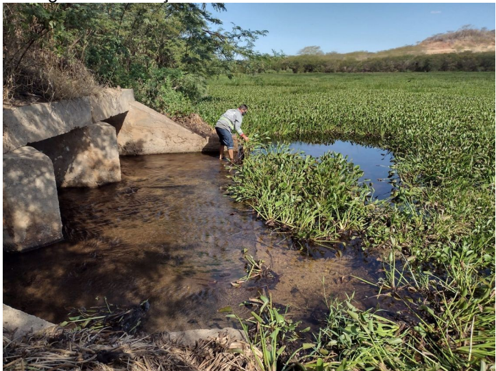
Sangradouro do açude Pedra
