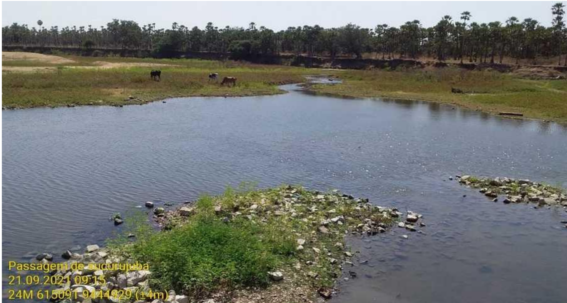
Vista de jusante da passagem molhada, 21/09/2021
