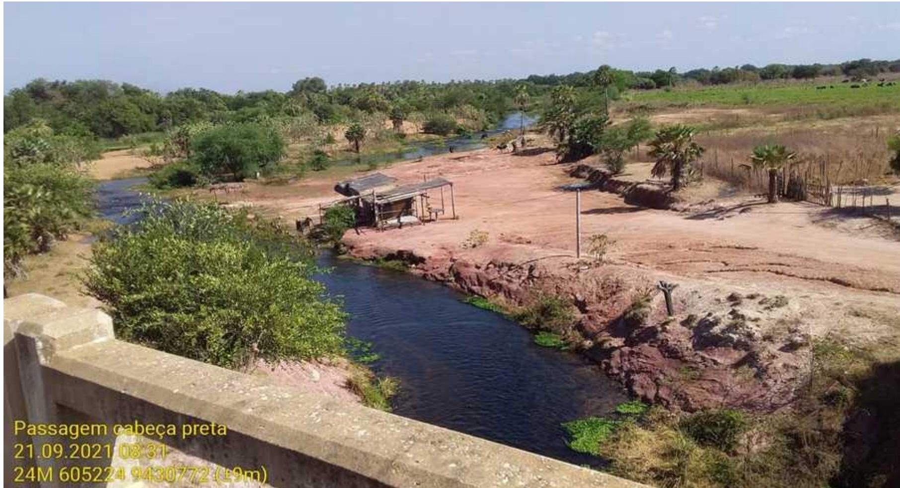
Vista de jusante da passagem Cabeça Preta, 21/09/2021
