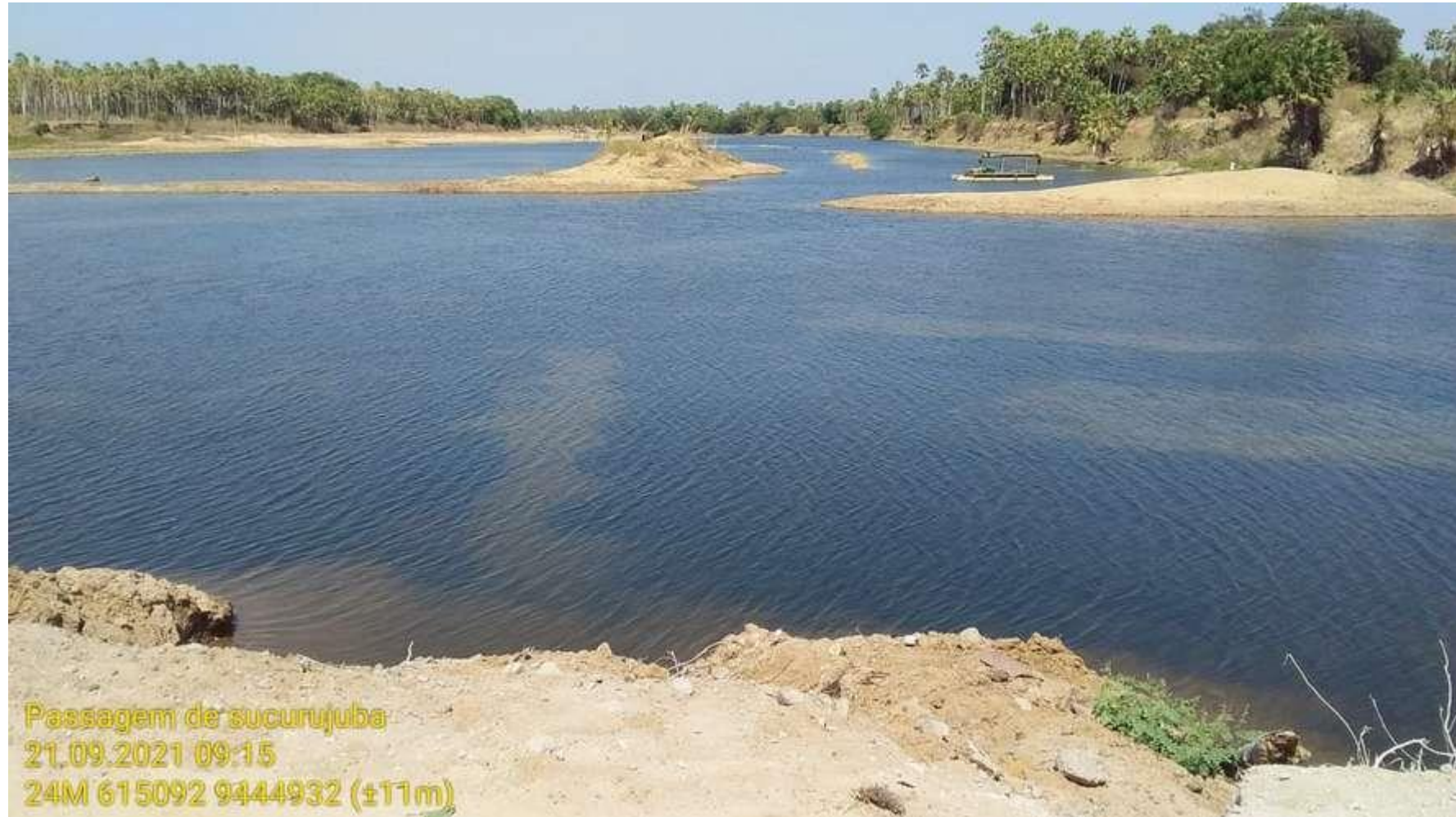
Vista de montante da passagem molhada, 21/09/2021
