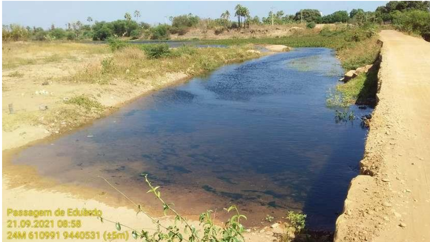
Vista de montante da passagem molhada, 21/09/2021
