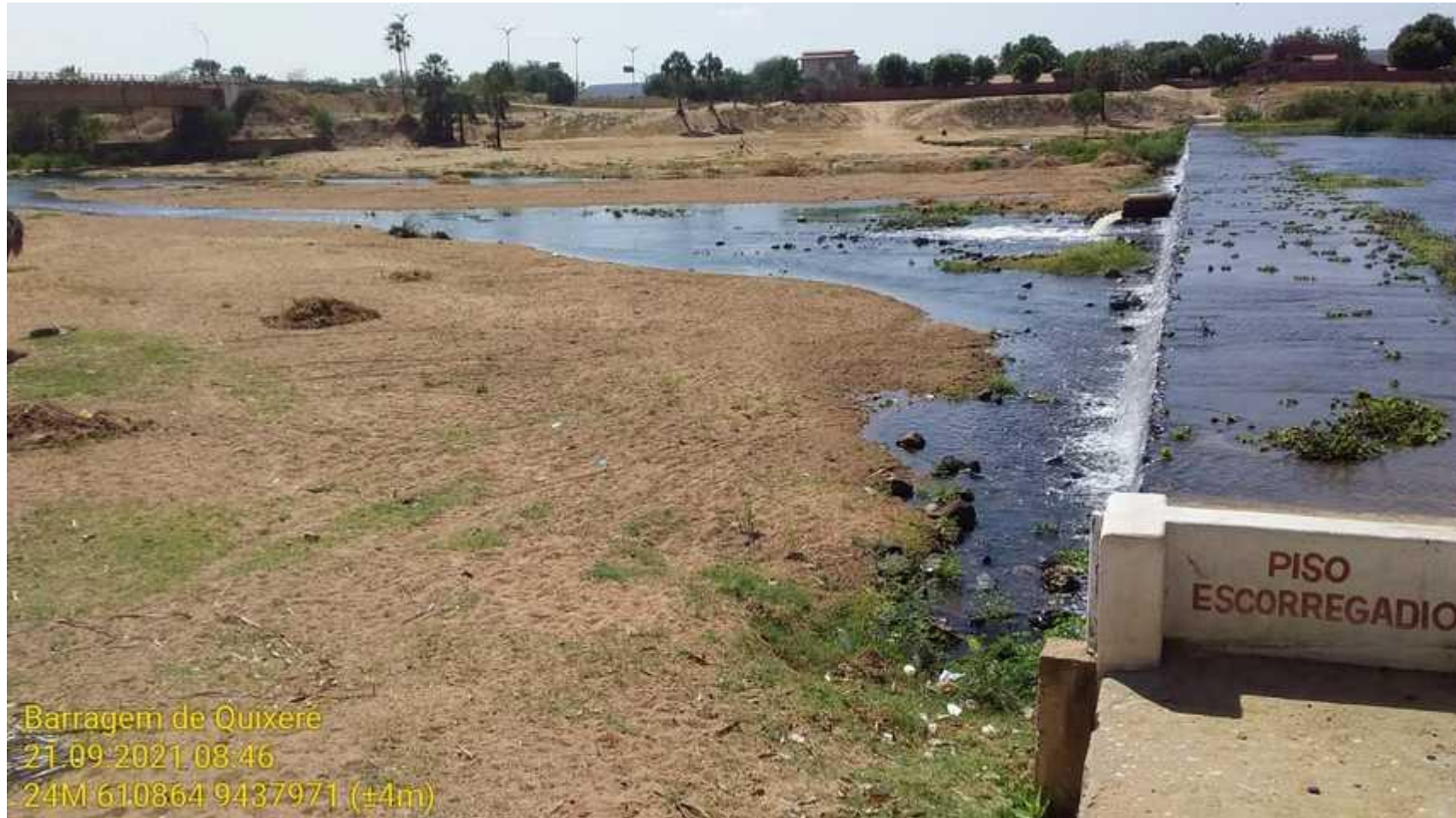
Vista de jusante da passagem molhada, 21/09/2021
