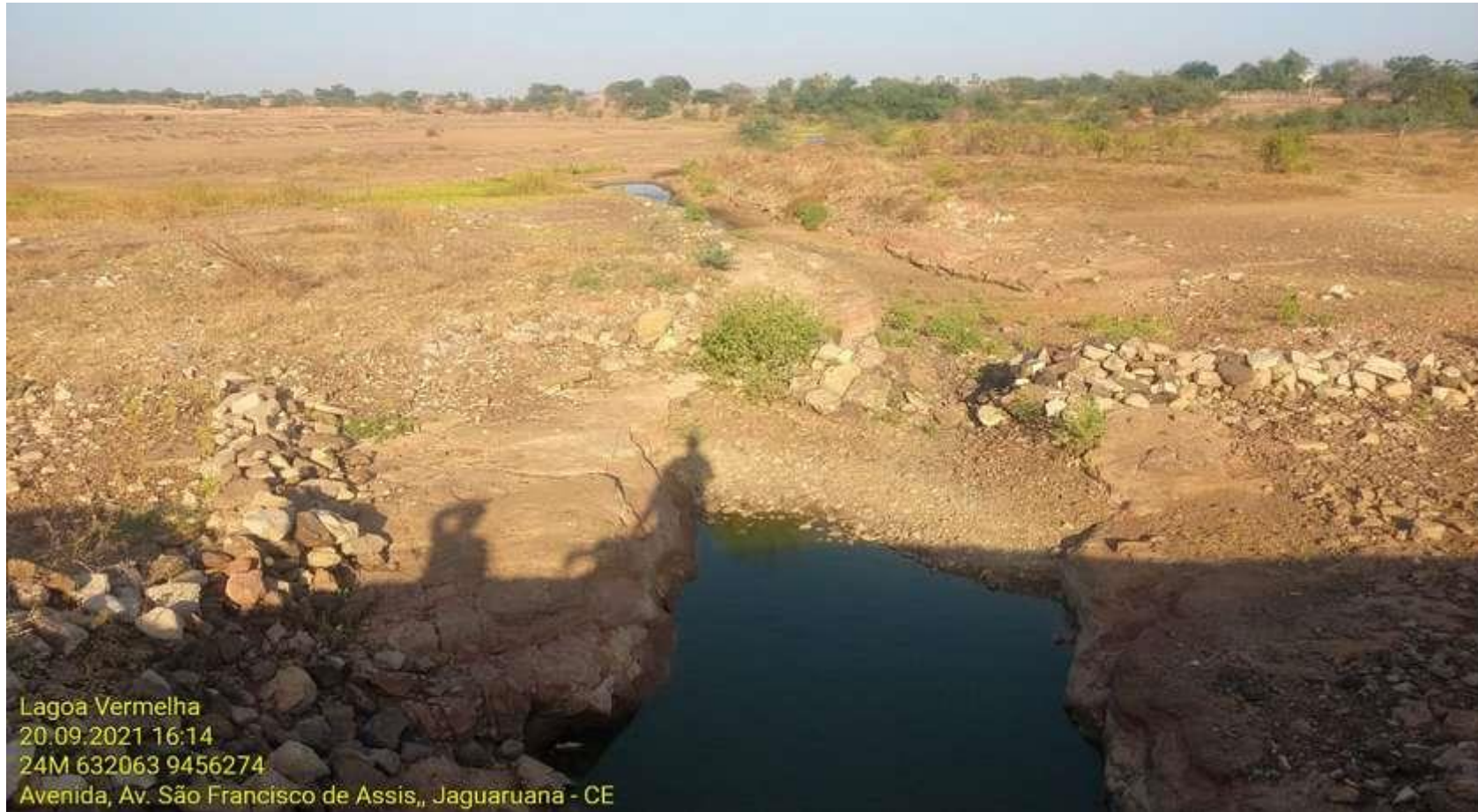
Vista da passagem molhada, 20/09/2021
