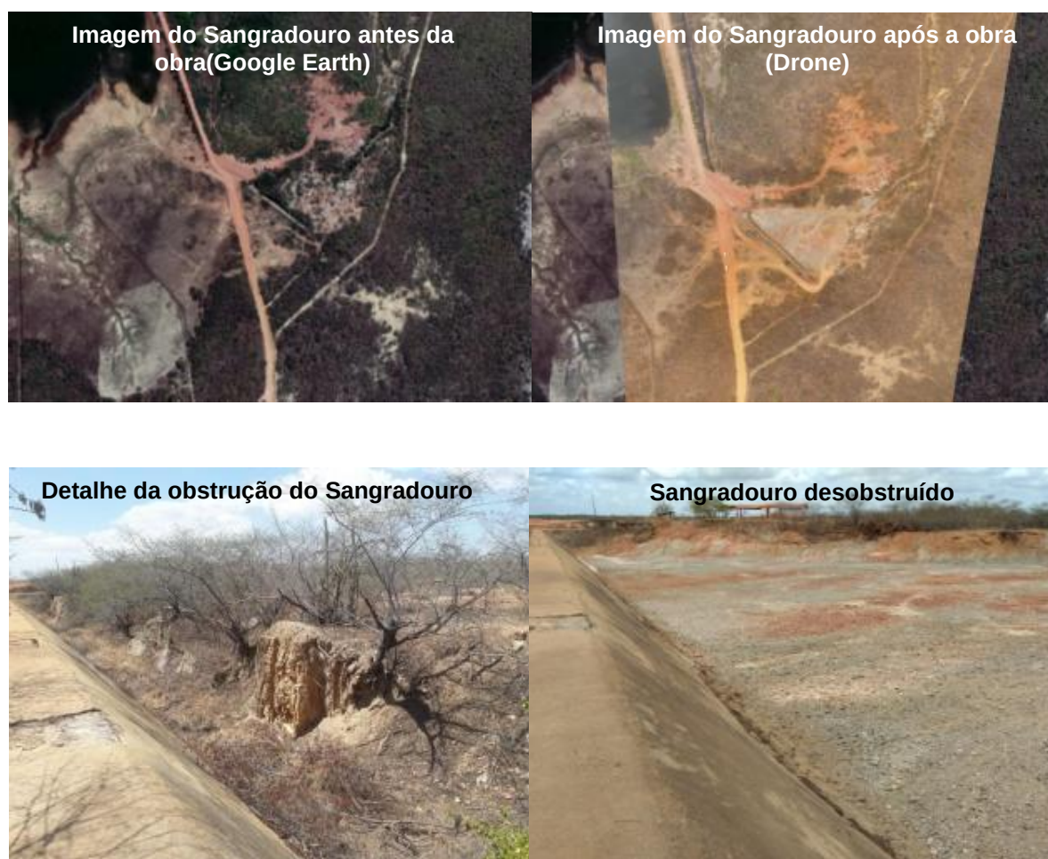
Figura 2 - Desobstrução do vertedouro da barragem Antônio da Silva no distrito de Medeiros
