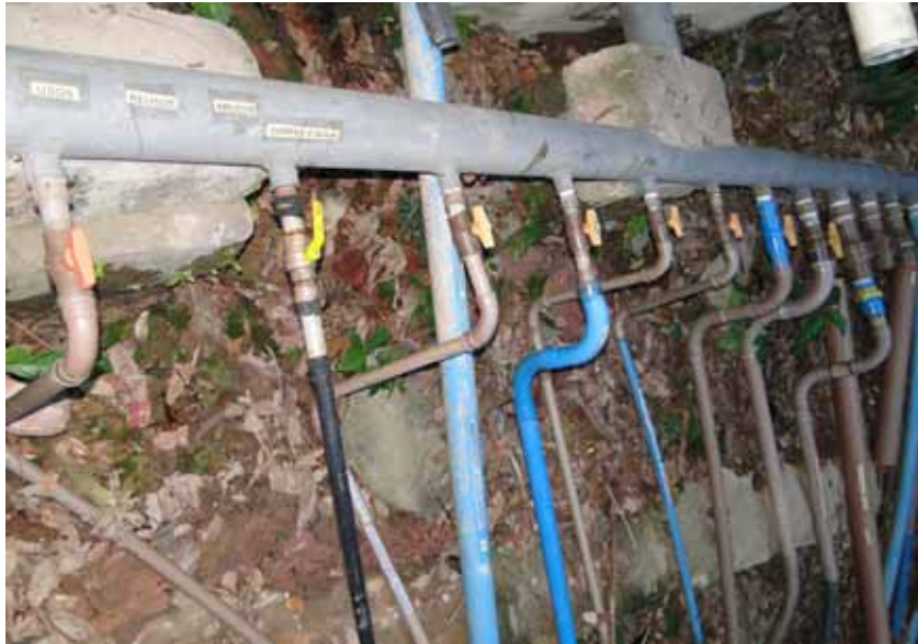
Figura 18 – Vista da distribuição da água de acordo com os volumes outorgados da Fonte Batateiras, Município de Crato (UTM 9197582N / 448007E – 09.09.2010).
